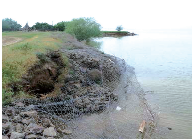
Фото 14, 15. Берегоукрепление в х. Овчинников Дубовского района до и во время весеннего половодья
