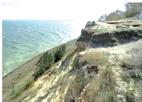
Рис. 8. Активный обвально-оползневой уступ в г. Цимлянске рядом с архитектурным памятником «Ротонда» (фото Южного отделения филиала ЮРЦ ГМСН ФГБУ «Гидроспецгеология»)
