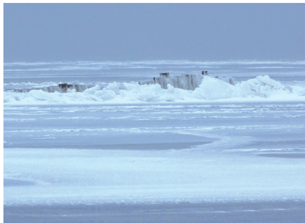
Фото 13. Инженерное сооружение у х. Веселый Котельниковского района Волгоградской области
