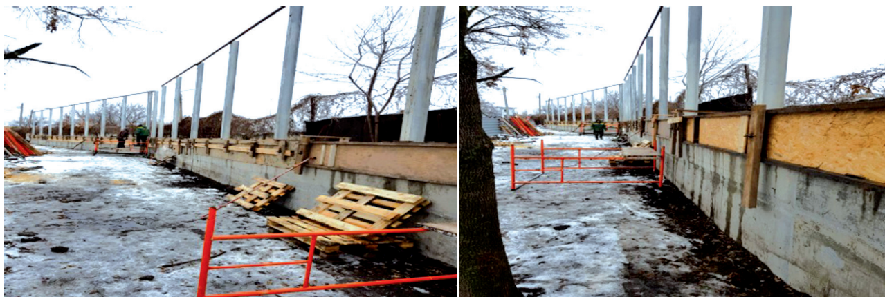
Проведение работ по установке шумоизоляционных экранов
