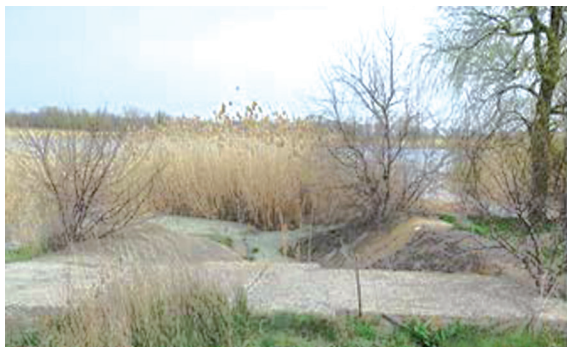
Фото 24. Выпуск ливневых сточных вод водовыпуске № 4 – ВК-6, г. Волгодонск № 2 – ДК-10
