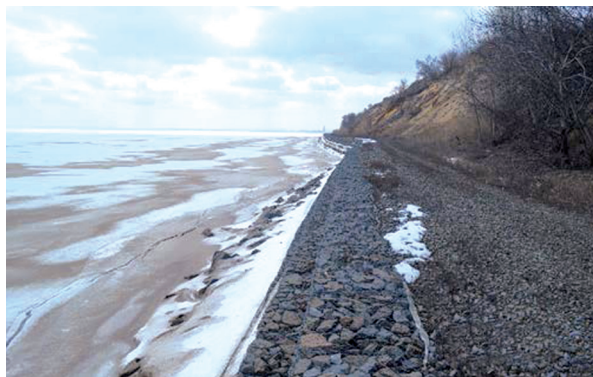
Фото 18, 19. Берегоукрепление Цимлянского водохранилища в черте г. Цимлянска Цимлянского района Ростовской области до начала и в период прохождения половодья
