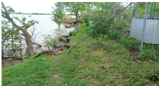
Фото 8. Обрушение коренного берега в границах садоводческого кооператива «Мирный Атом» г. Волгодонска Ростовской области
